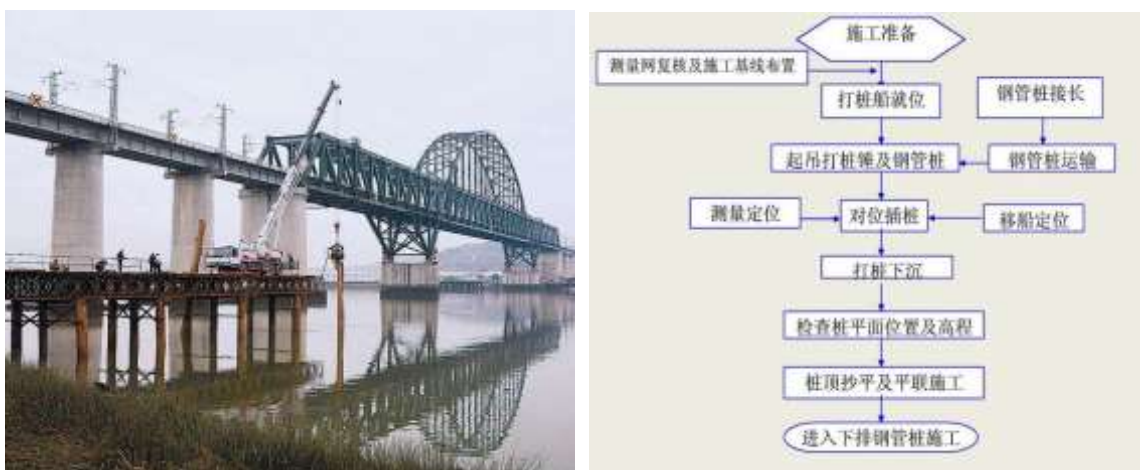
图 7.5-3 栈桥结构形式及施工工艺流程
