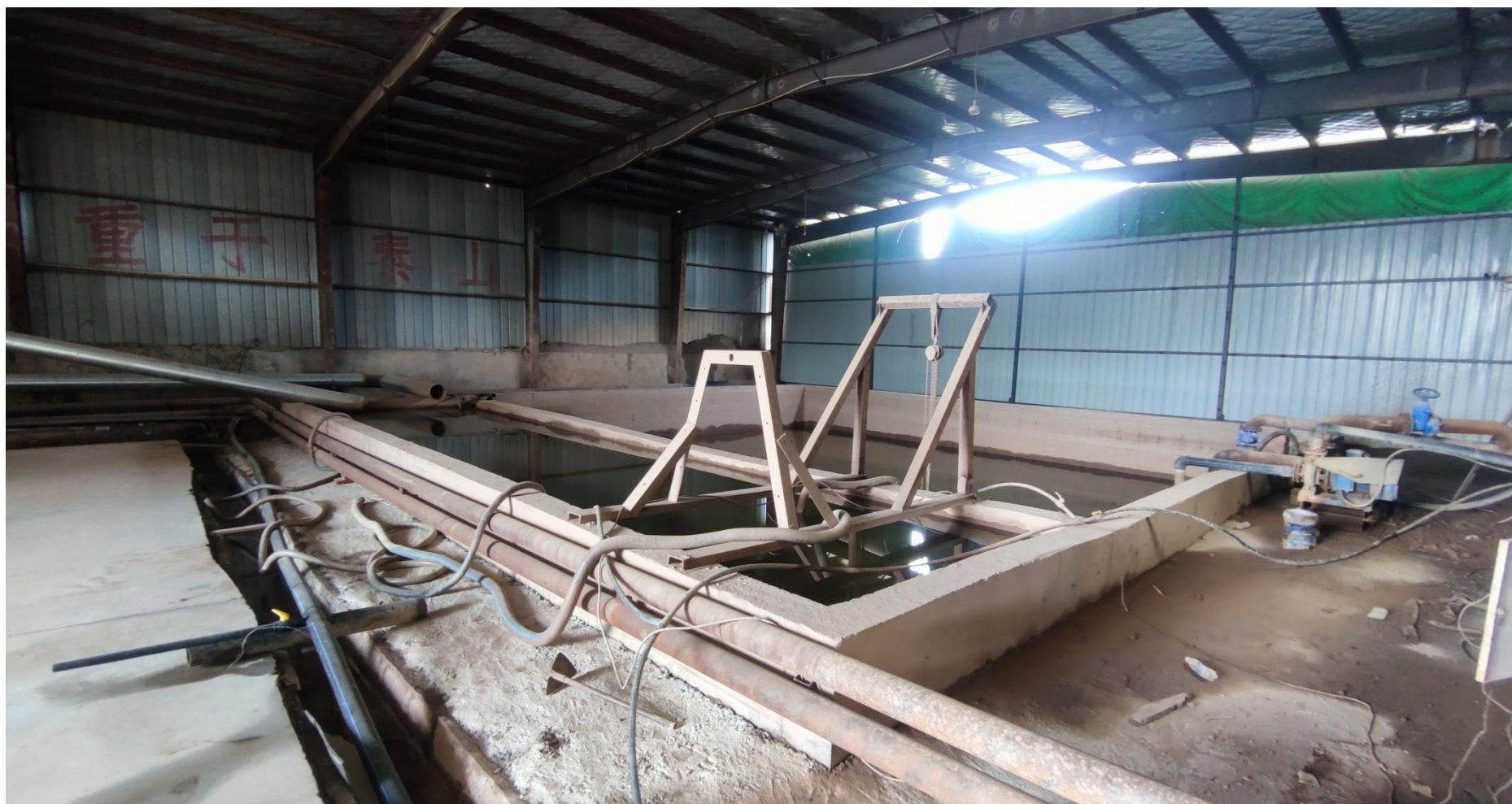
新建洗砂废水沉淀池已建设完成
