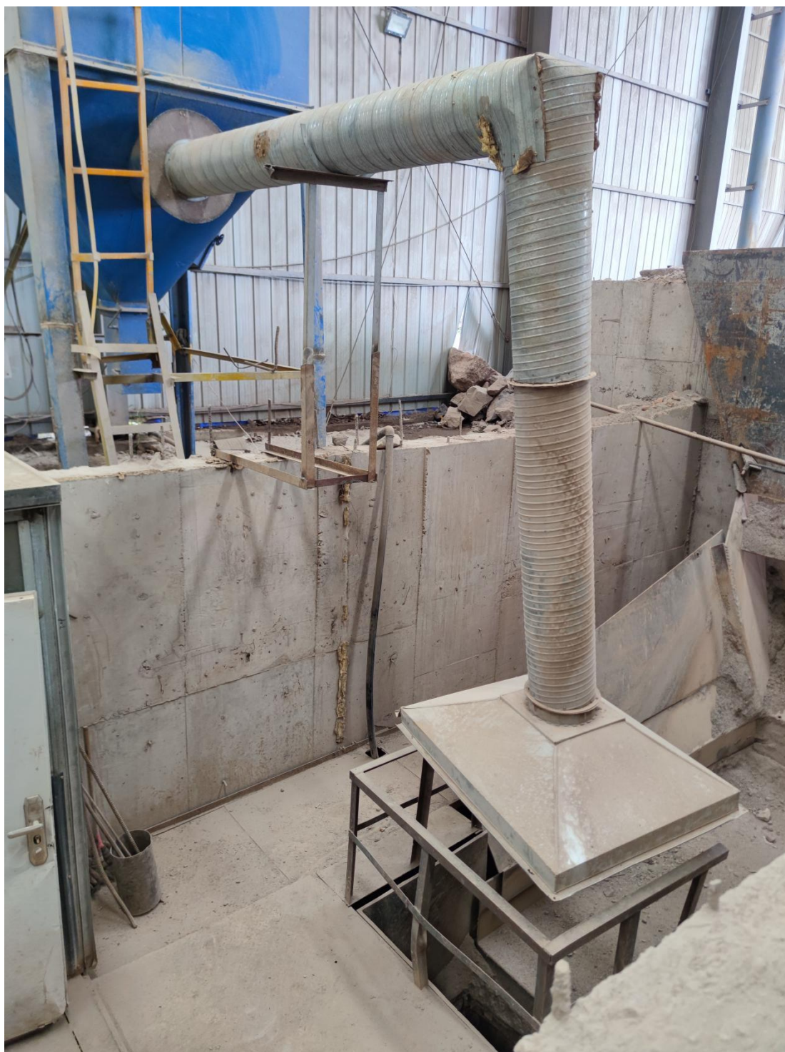
修复加工区破碎口收尘罩
